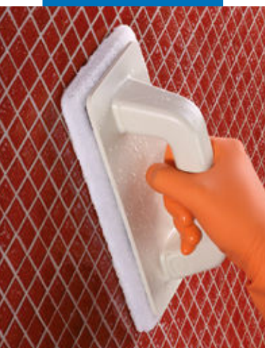
Curățarea finală a mozaicului din sticlă cu un pad Scotch Brite® umed
